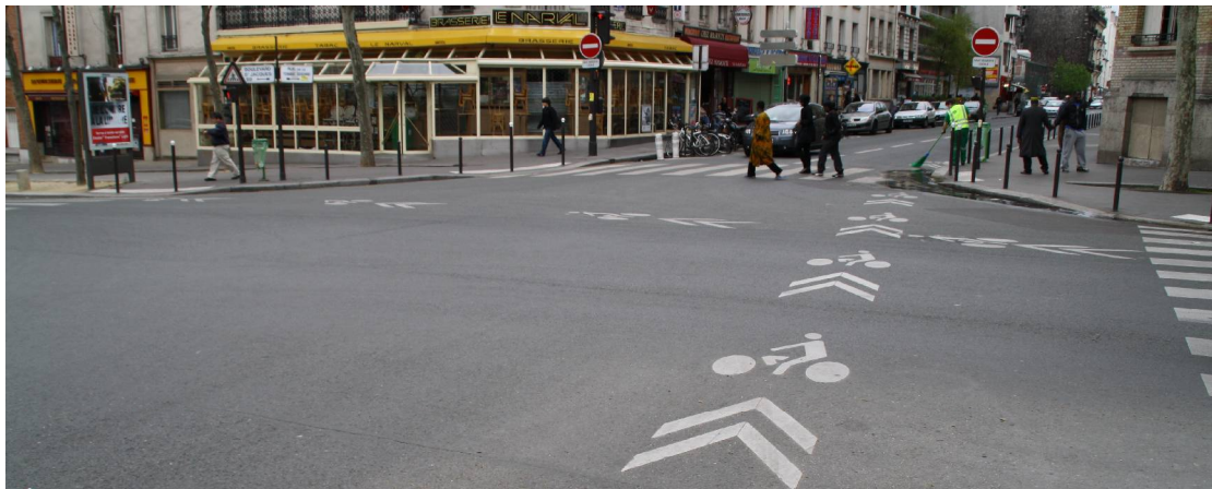
vyznačení hlavní a vedlejší komunikace pomocí piktogramů pro cyklisty (vedlejší koridor je přerušen)
